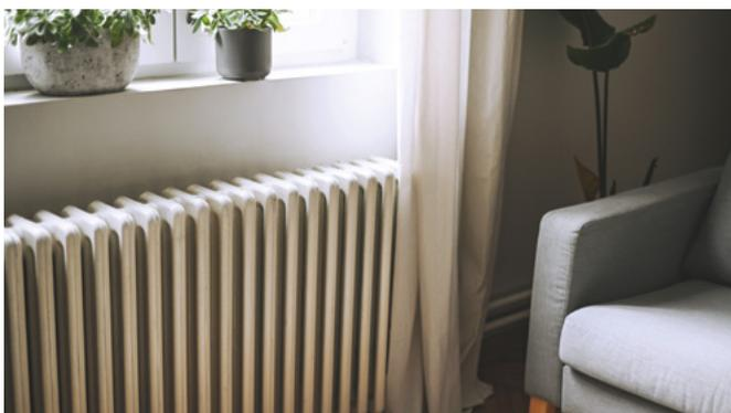
Außenwänden stehen. Gelangt zu wenig Wärme an diese Wände, sinkt die Oberflächentemperatur und das Risiko der Schimmelpilzbildung steigt.
