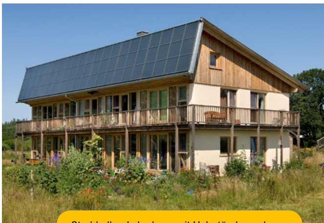
Strohballen-Lehmhaus mit Holzständerwerk
