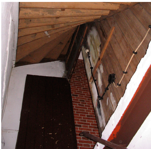
Ungedämmter Kellerabgang Quelle: Bonner Energie Agentur
