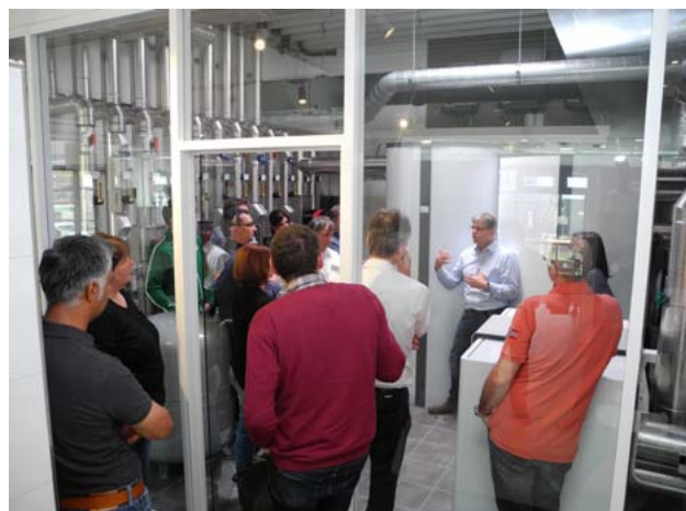
Besichtigung der Heizzentrale im neuen „Roten Haus“ der Firma Küpper in Bonn-Pützchen, Quelle: BEA
