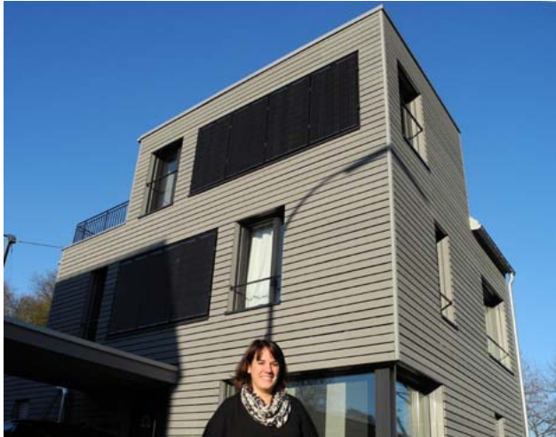
Presstetermin beim Neubau der Familie Jarrot, mit PV-Modulen an der Fassade und Batteriespeicher im Keller, Quelle: BEA
