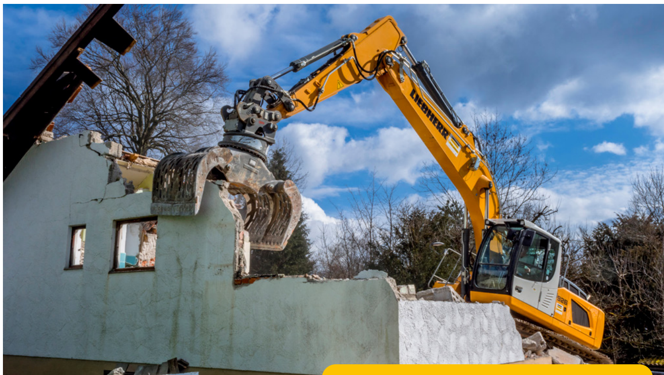
Kontrollierte Demontage für die Wiederverwendung von Baumaterialien
