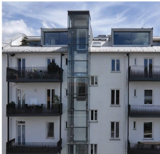
Die weniger schmuckreiche Hoffassade des Gebäudes aus dem 19. Jahrhundert wurde energetisch saniert und darüber hinaus für die barrierefreie Erschließung der oberen Geschosse mit einem Aufzug versehen. Dichter innerstädtischer Wohnraum konnte so revitalisiert und die schmuckreiche, repräsentative Straßenseite differenziert gestaltet und somit den angrenzenden Fassaden angepasst werden. München, Unterlandstättnr Architekten, 2010
